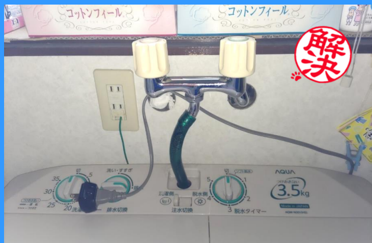
洗濯機の水道蛇口を修理しました。
