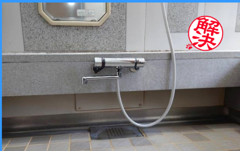
お風呂場のシャワー蛇口を交換修理しました。
