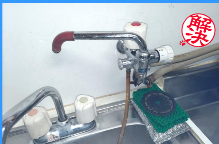
台所の温水道蛇口を修理しました。
