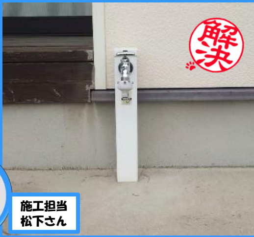
外の水道の漏水を修理しました。
