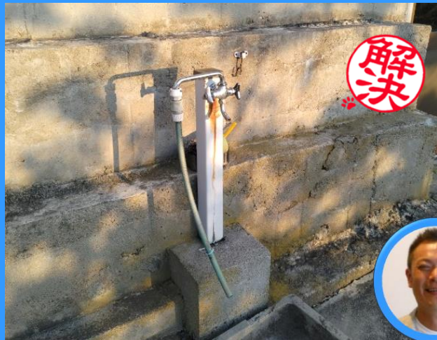
外の水道の漏水を修理しました。
