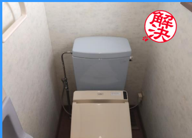
トイレのタンクの漏水を修理しました。
