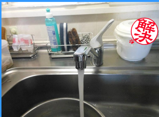
台所の水道蛇口を交換修理しました
