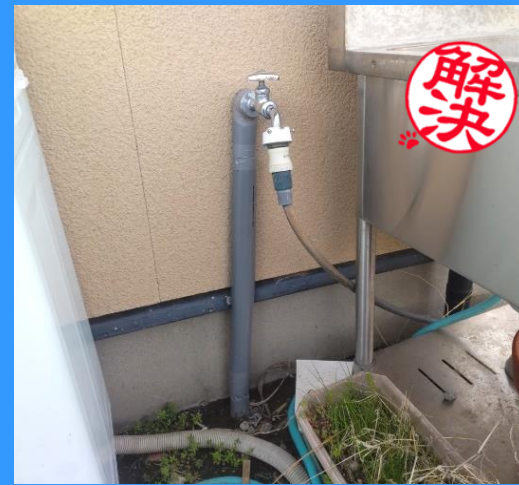
外の水道の漏水を修理しました。
