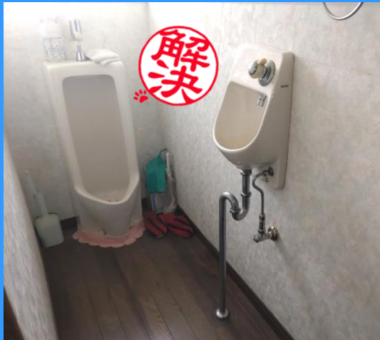
トイレ手洗場の漏水を修理しました。
