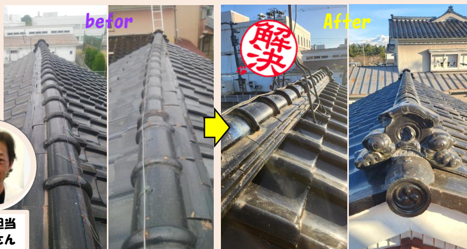
自宅の棟積み直し、瓦修繕工事を行いました。
