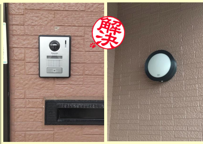
インターホン、照明器具を交換取付しました。
