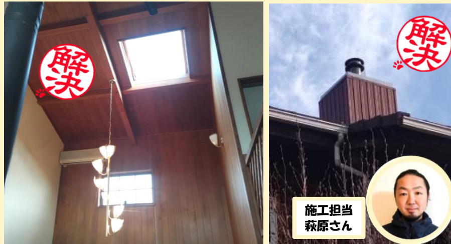
施工担当 萩原さん 自宅の天窗、煙突まわりの雨漏り防水工事を行いました。
