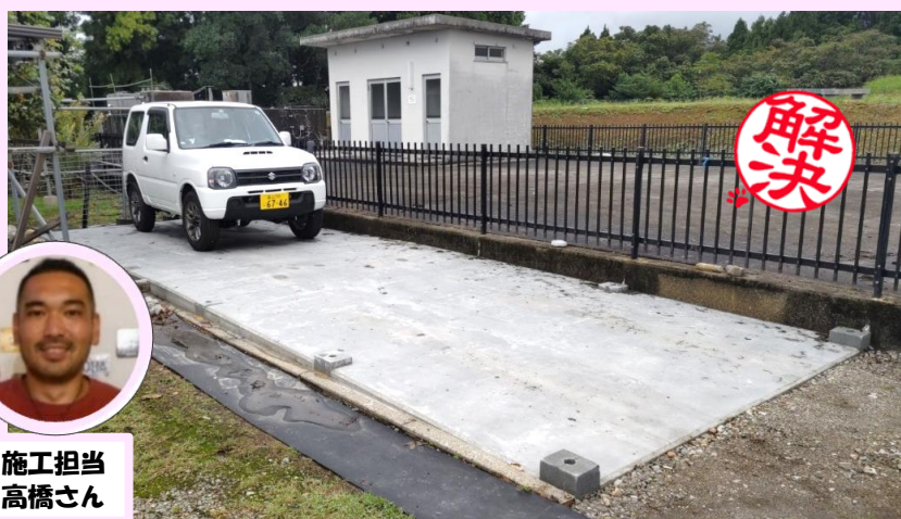
駐車スペースの整備を行いました。
