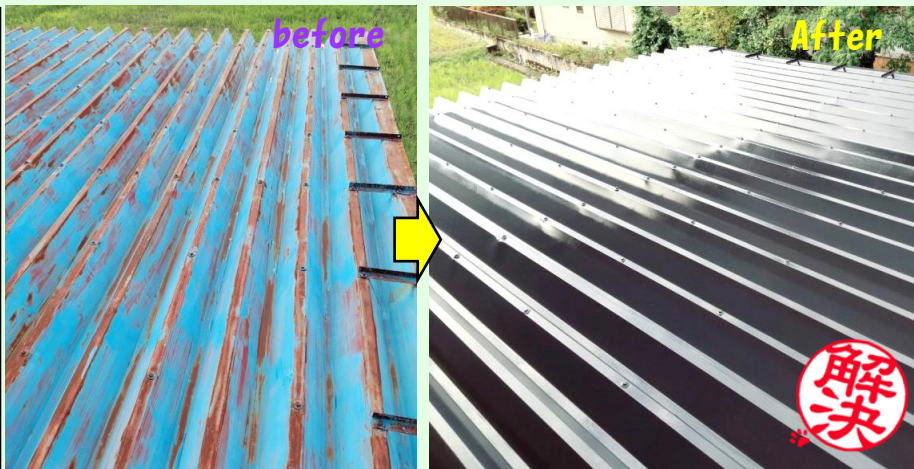
車庫の屋根塗装工事を行いました。
