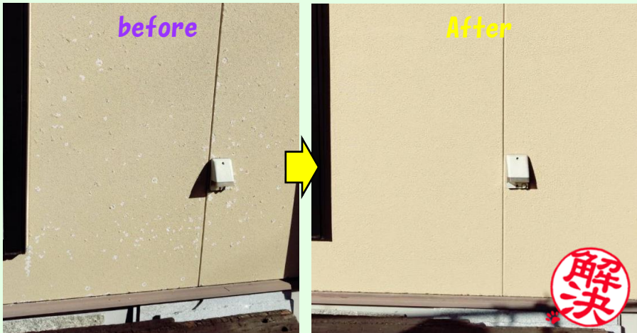
外壁の修繕塗装工事を行いました。
