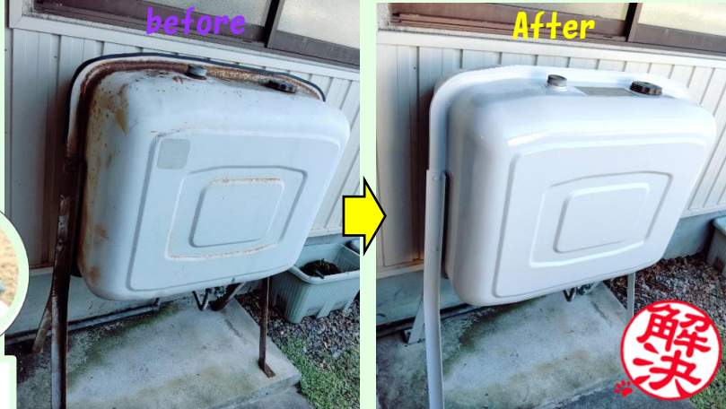
灯油タンクの塗装工事を行いました。
