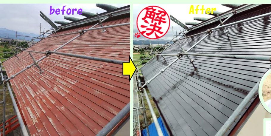
神明社の屋根塗装工事を行いました。
