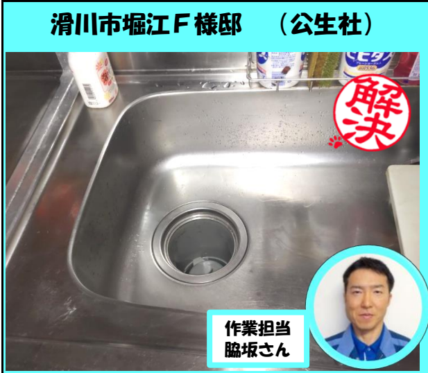
滑川市堀江F様邸 (公生社) 排水管の詰まりを直しました。
