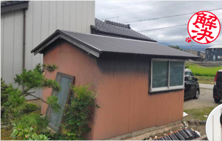
納屋のトタン屋根を修繕しました。
