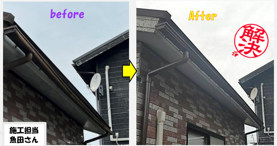
傷んだ雨どいを修繕しました。
