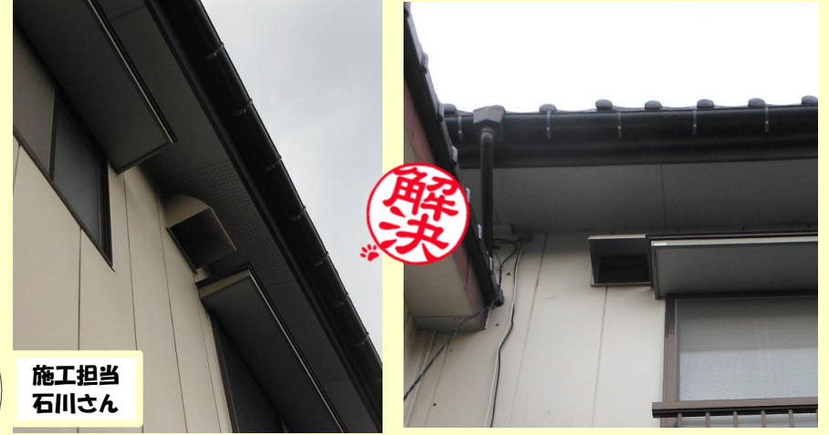
複数箇所換気扇のフードを交換しました。
