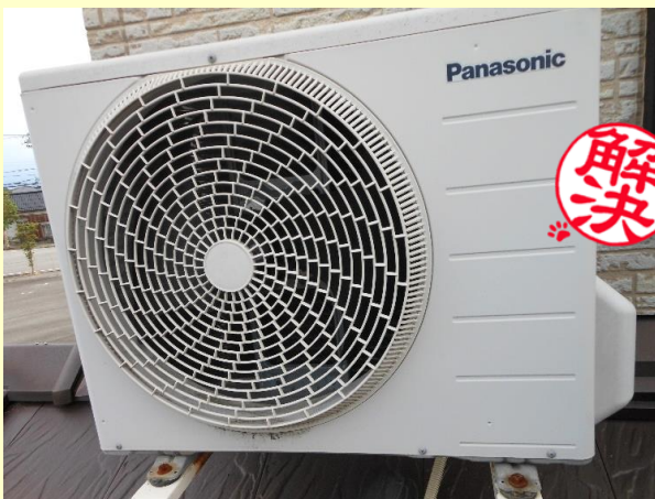
エアコン室外機のガス漏れを修理しました。
