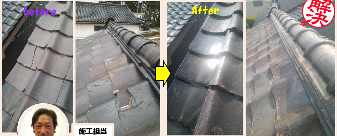
棟積み直し工事、瓦修繕工事を行いました。
