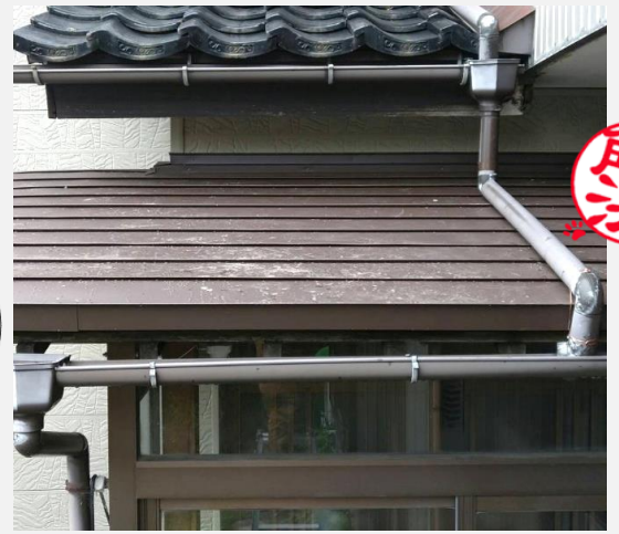
玄関ポーチ屋根を修繕しました。
