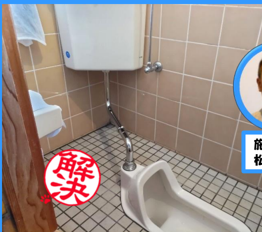
トイレの水漏れを修繕しました。
