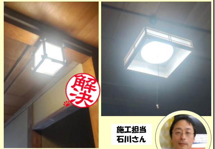
照明器具を交換しました。
