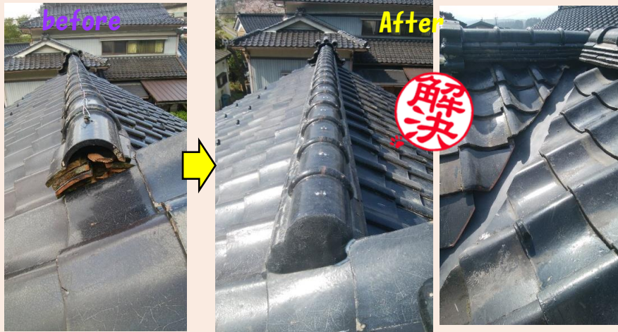
棟積み直し、ステンレス板入れ替え工事を行いました。
