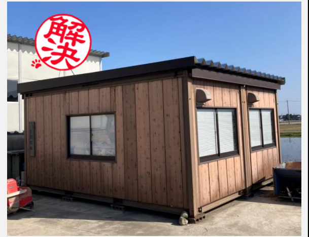
フレハフの改修板金工事を行いました。
