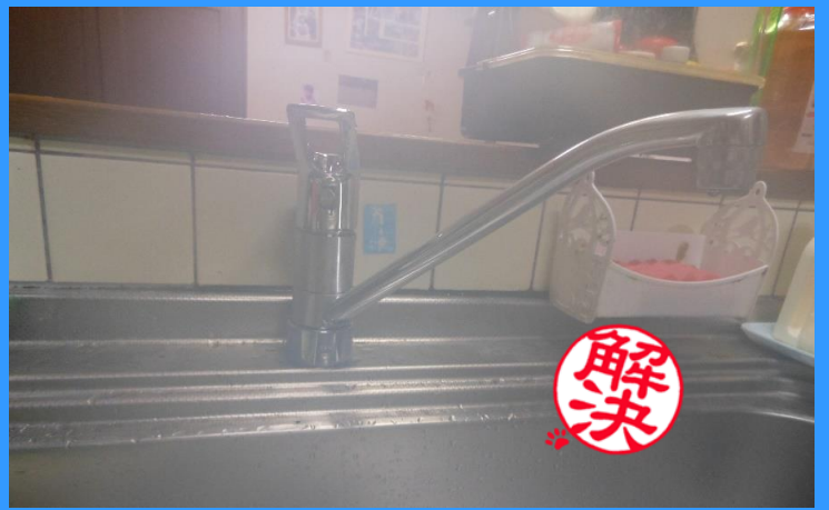
水漏れしていた台所の蛇口を交換しました。
