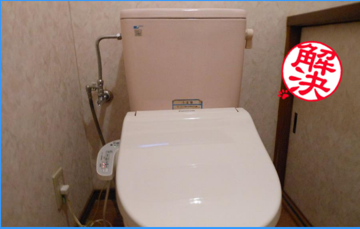
水漏れしていたトイレのタンクを修繕しました。
