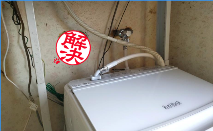
水漏れしていた洗濯機の水道を修繕しました。
