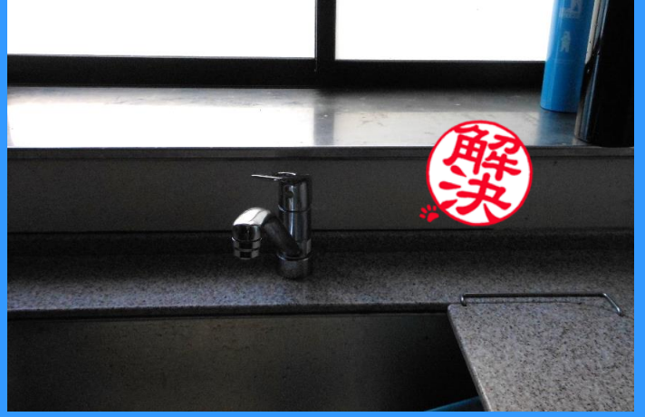
水漏れしていた台所の蛇口を交換しました。
