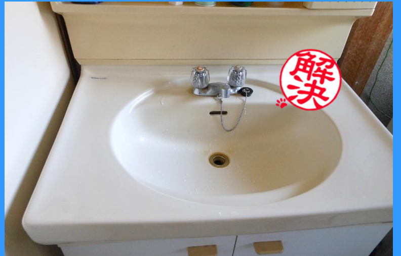
洗面所の蛇口を交換・修繕しました。
