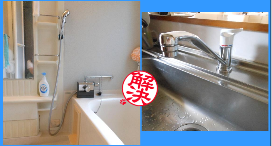
お風呂場・台所蛇口などを交換・修繕しました。
