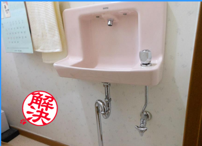
トイレの手洗いの配管を修繕・調節を行いました。
