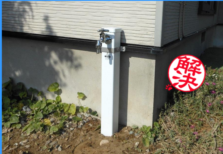
使えなかった外の水道蛇口を使えるように修繕しました。
