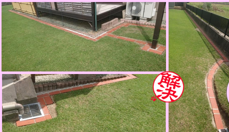
お庭全体の排水溝などの修繕工事を行いました。
