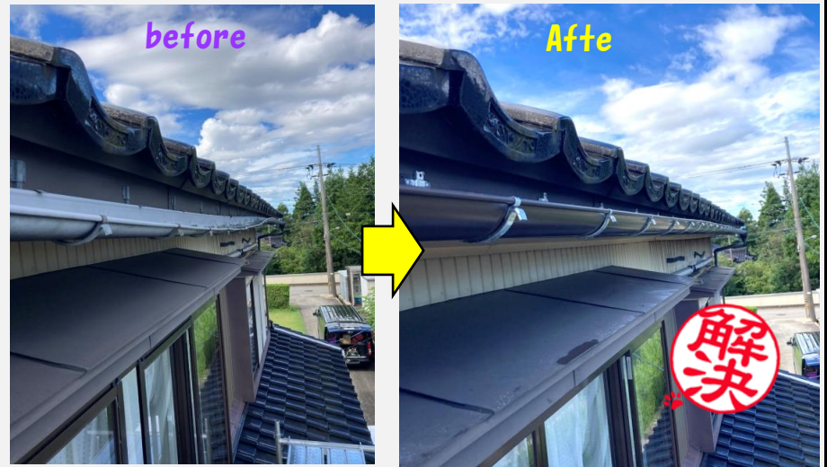
雨どい各所を交換・修繕しました。
