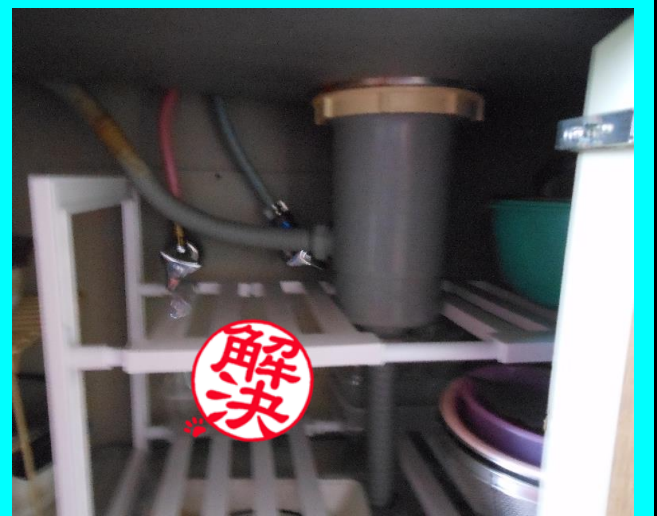
台所流しの排水管詰まりを直しました。
