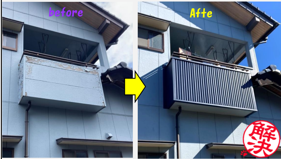
経年劣化で傷んだ2階のバルコニーをリフォームしました。
