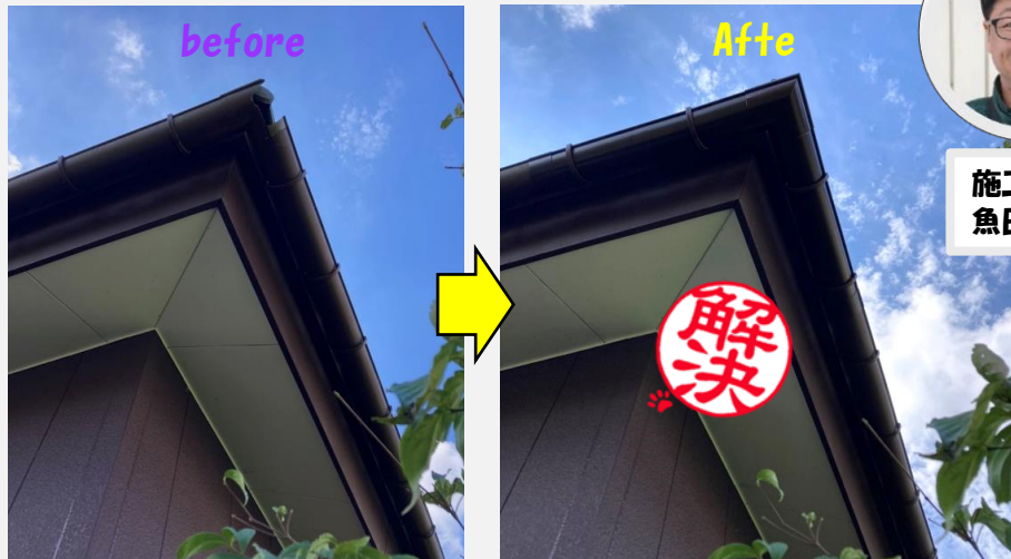
雨どい各所を交換・修繕しました。
