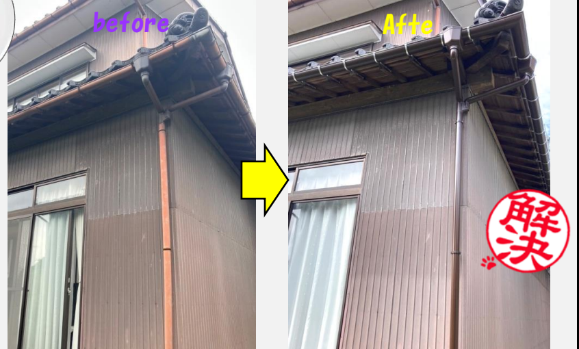
雨どい各所を交換・修繕しました。
