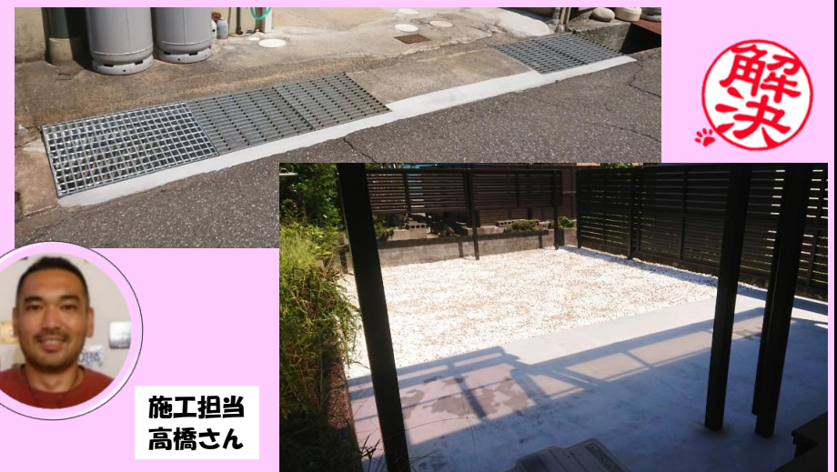
玄関前の側溝周辺修繕、お庭の土間工事などを行いました。
