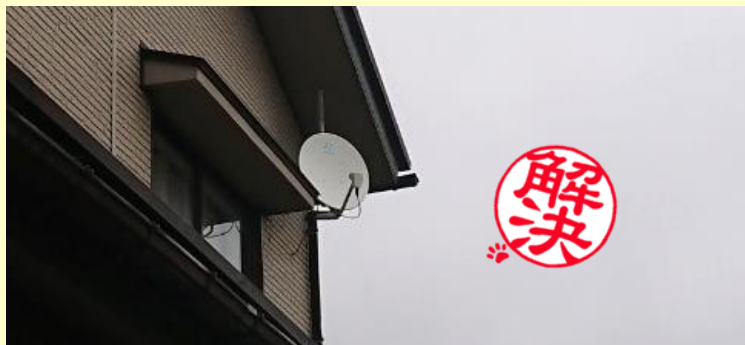
傷んだBSアンテナを交換しました。
