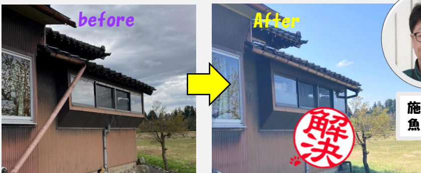
傷んだ雨どいを修繕しました。
