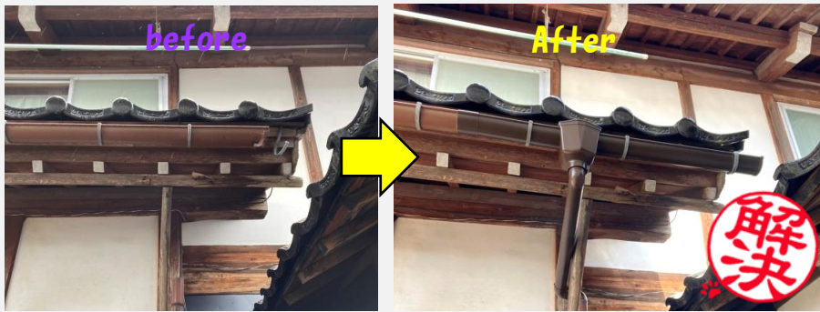
傷んだ雨どいを修繕しました。
