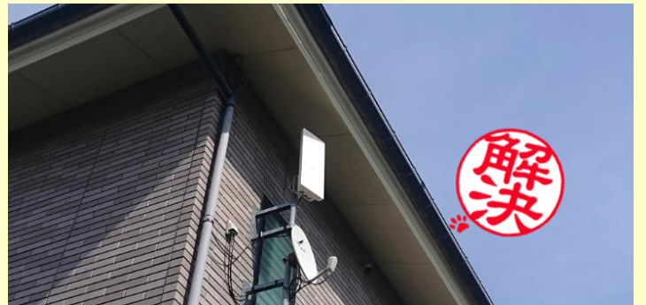
老朽化したアンテナを平面タイプに交換しました。
