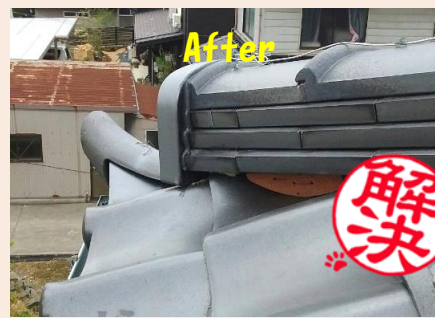
冠瓦、のし瓦など傷んだ屋根瓦を修繕しました。
